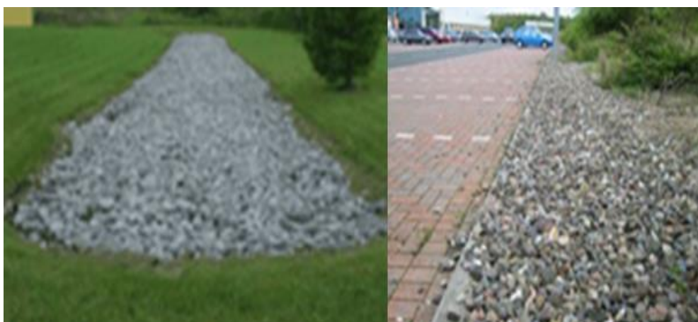
20. ábra: Parkolók lefolyásának bevezetése füvesített vagy kavicsöltésű szivárogtató árkokba
