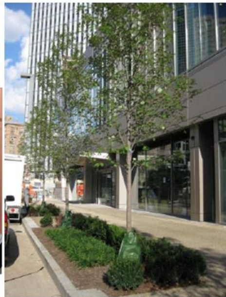
21. ábra: Parkoló és útfelület lefolyásának szikkasztása fásított szikkasztórendszerrel
