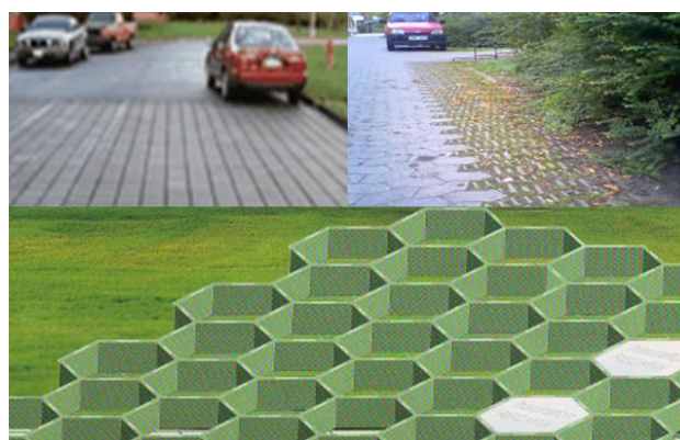
18. ábra: A parkolók vízáteresztő felületű kialakítása
