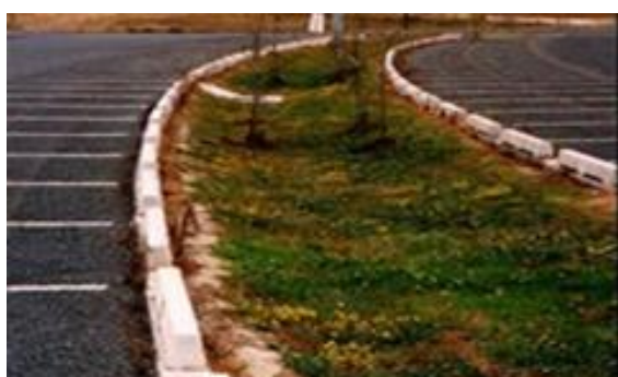
19. ábra: Az utcáról és a járdáról lefolyó vizek rávezetése burkolatlan, füvesített árokba (egy- és kétoldali)
